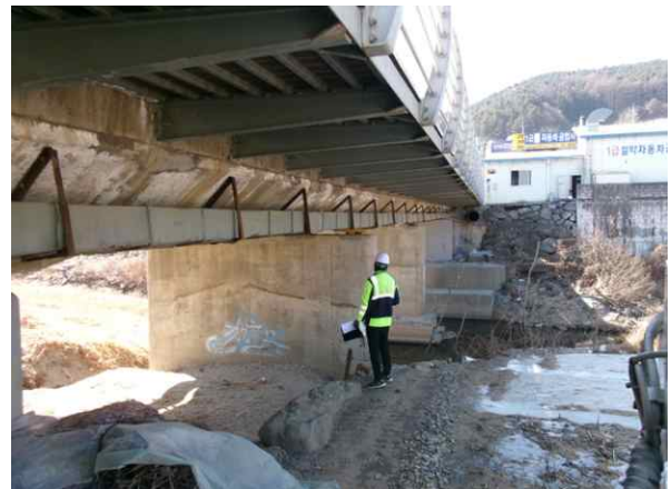
도보를 통한 작업전경
