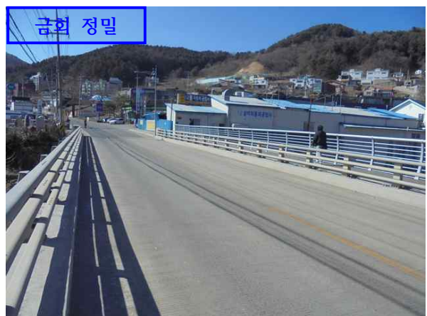
교면포장 재포장(콘크리트 포장)
