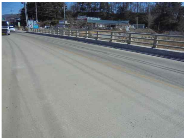
교면포장 S1~S2 전경
