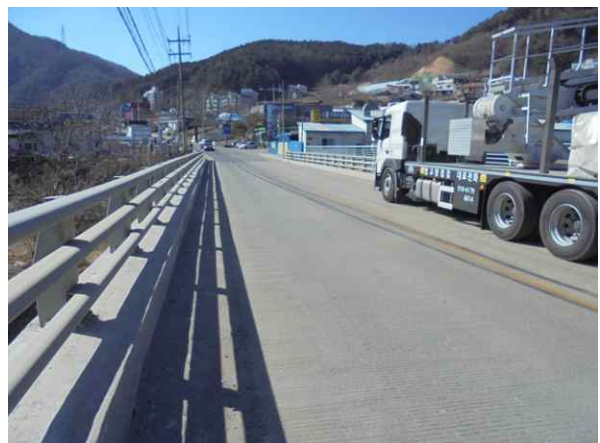
교면포장 S3~S4 전경
