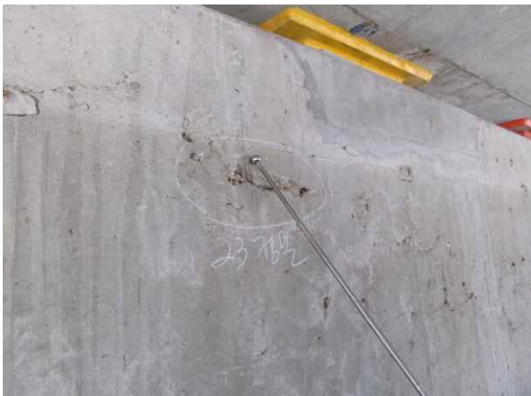
콘크리트 들뜸 작업전경
