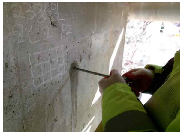
탄산화깊이 측정 현황
